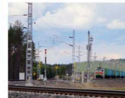
Keitele Groupin Kemijärven tuotantolaitokset sijaitsevat Patokankaan teollisuusalueella. Sieltä sähköistetty ratayhteys valtakunnalliseen rautaverkkoon.
